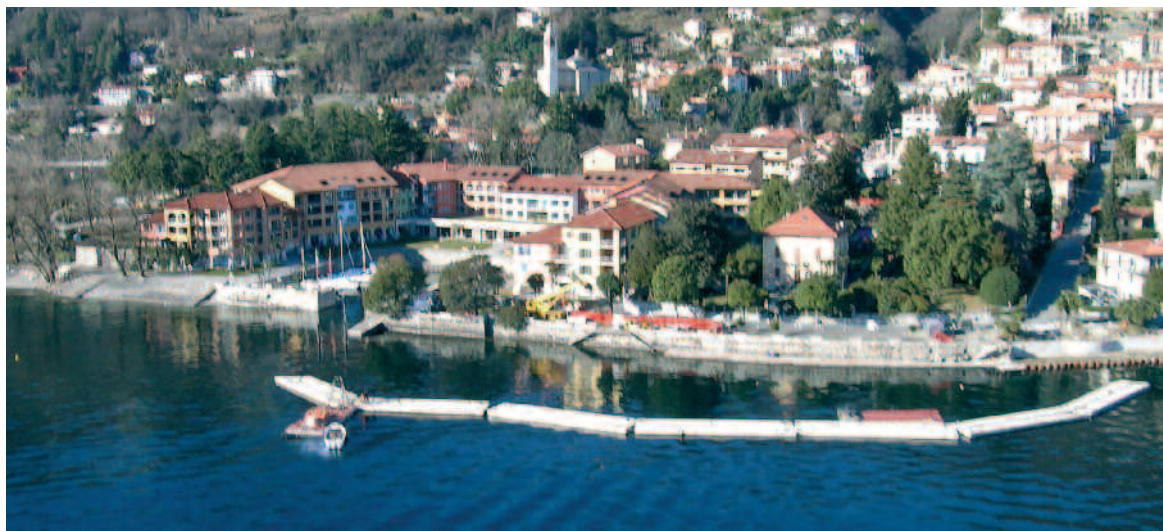
Cannero, porto in costruzione
