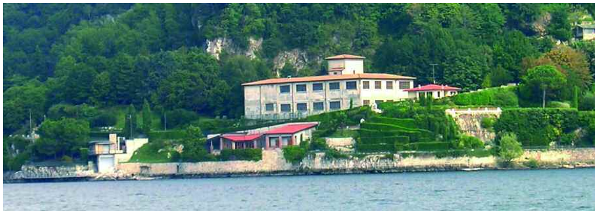
Punto cospicuo; una grande costruzione.
