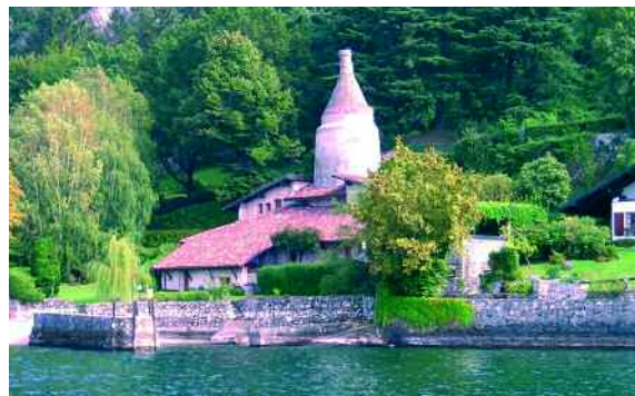
Darsena abbandonata vicino ad una vecchia fornace.
